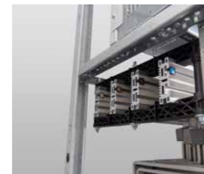
Completa accessibilità laterale
