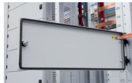
IP42: Plastron pivotant, équipé avec joint d'étanchéité IP42.
