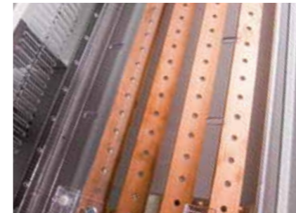
Jeu de barres vertical: jeu de barre monté dans la gaine à câbles.
