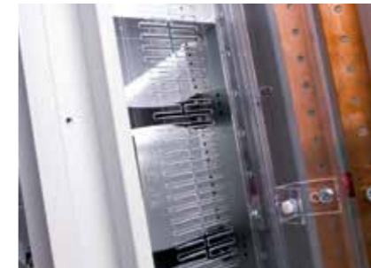
Cloisonnement latéral: pour gaine à câbles.
